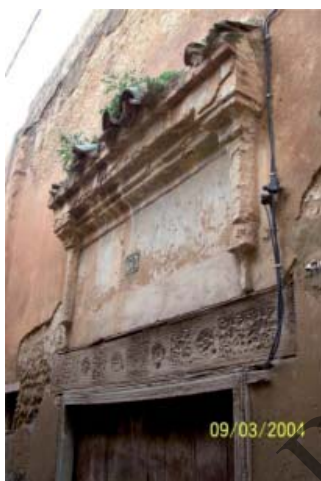
fig. 4 - porche d'entrée d'une maison attribuée à l'époque almoravide (remarquer le cadre en bois ciselé et la grosse poutre à décors gravés)
