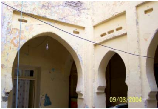
fig. 6 - Patio d'une maison zianide (Aucune décoration n'est conservée)
