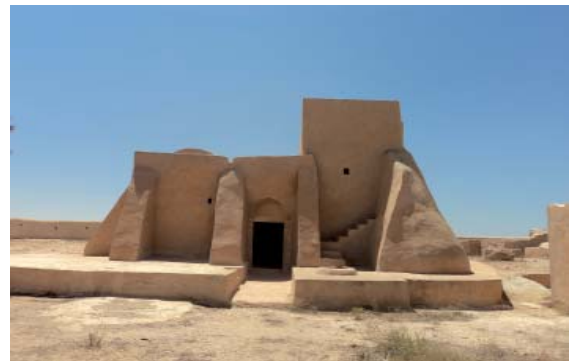
fig. 3 - La façade principale de la salle de prière de la mosquée Wilhi. Cliché de l'auteur, juin 2010.
